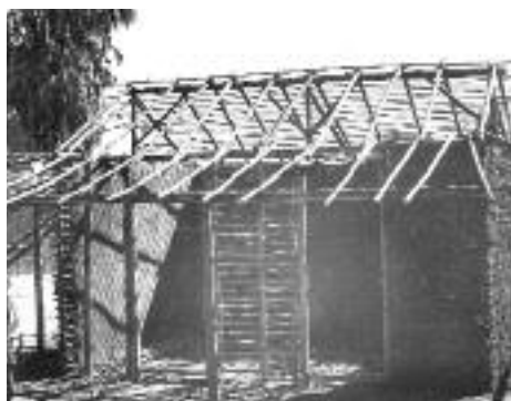
41. Maison à varangue en construction.
