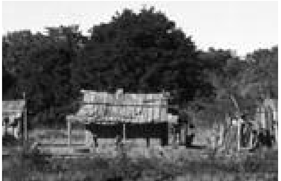
40. Maison en pisé. Le toit est recouvert de bardeaux en écorce de baobab.
